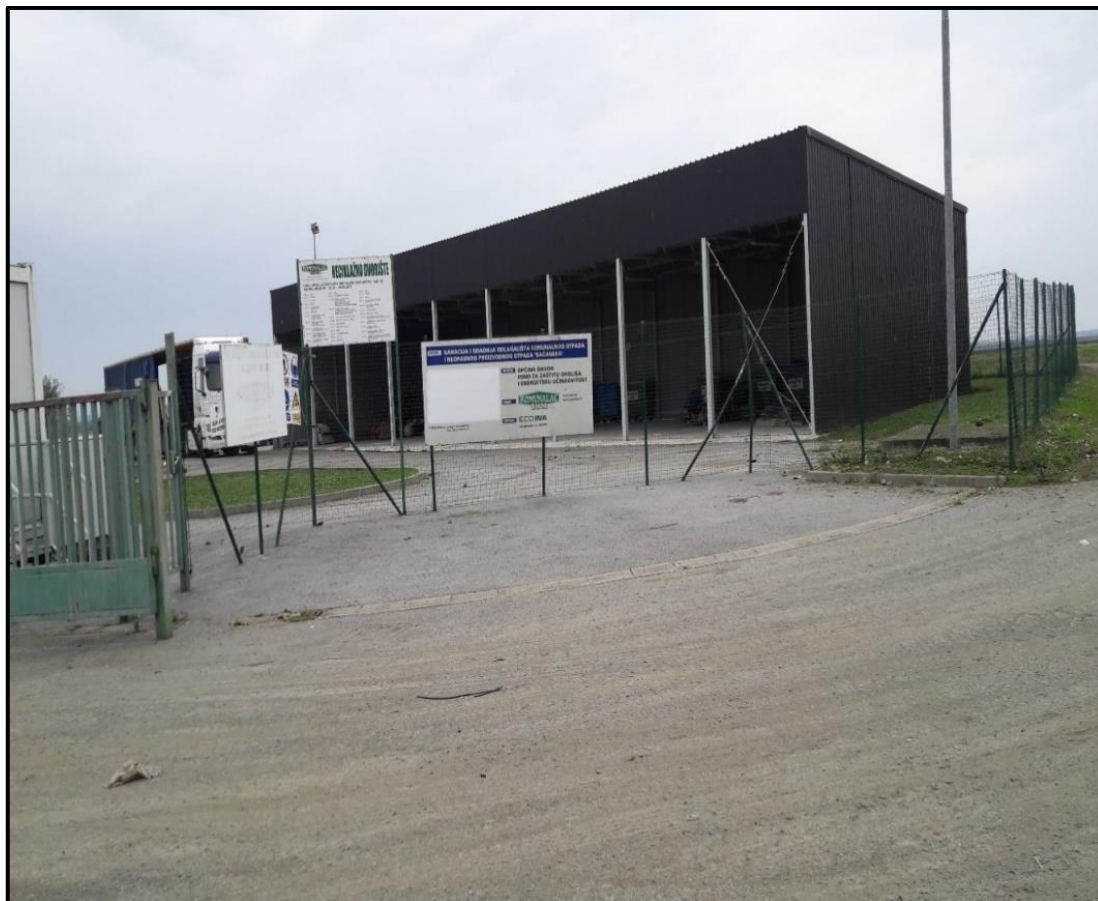
Slika 7 Reciklažno dvorište na području odlagališta otpada "Bačanska" (Izvor: Hidroplan d.o.o.)
